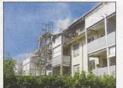
Balkonbrand an der Spitzwaldstrasse.
